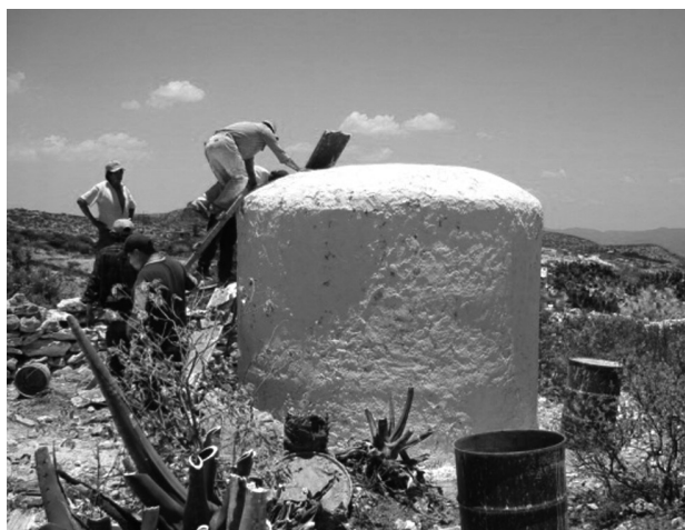
La primera tina de ferrocemento terminada.
