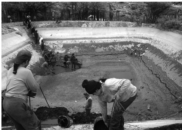
Las mujeres del frente uno desazolvando la segunda hoya.
