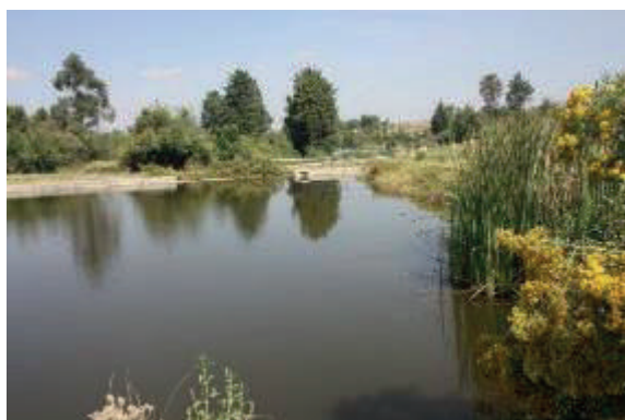
Figura 8. Presa Ocochaltepec, Ocuituco, Morelos. Abril 2015. NBGR
