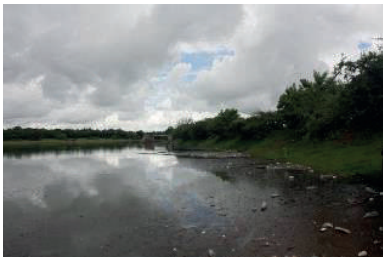
Figura 6. Presa Vista Hermosa, Ocuítuco, Morelos. Julio 2014. NBGR
